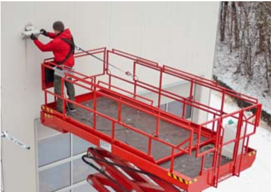
Abb. 4: Besonders in großen Arbeitskörben ist das Höhensicherungsgerät das optimale Sicherungsmittel.
