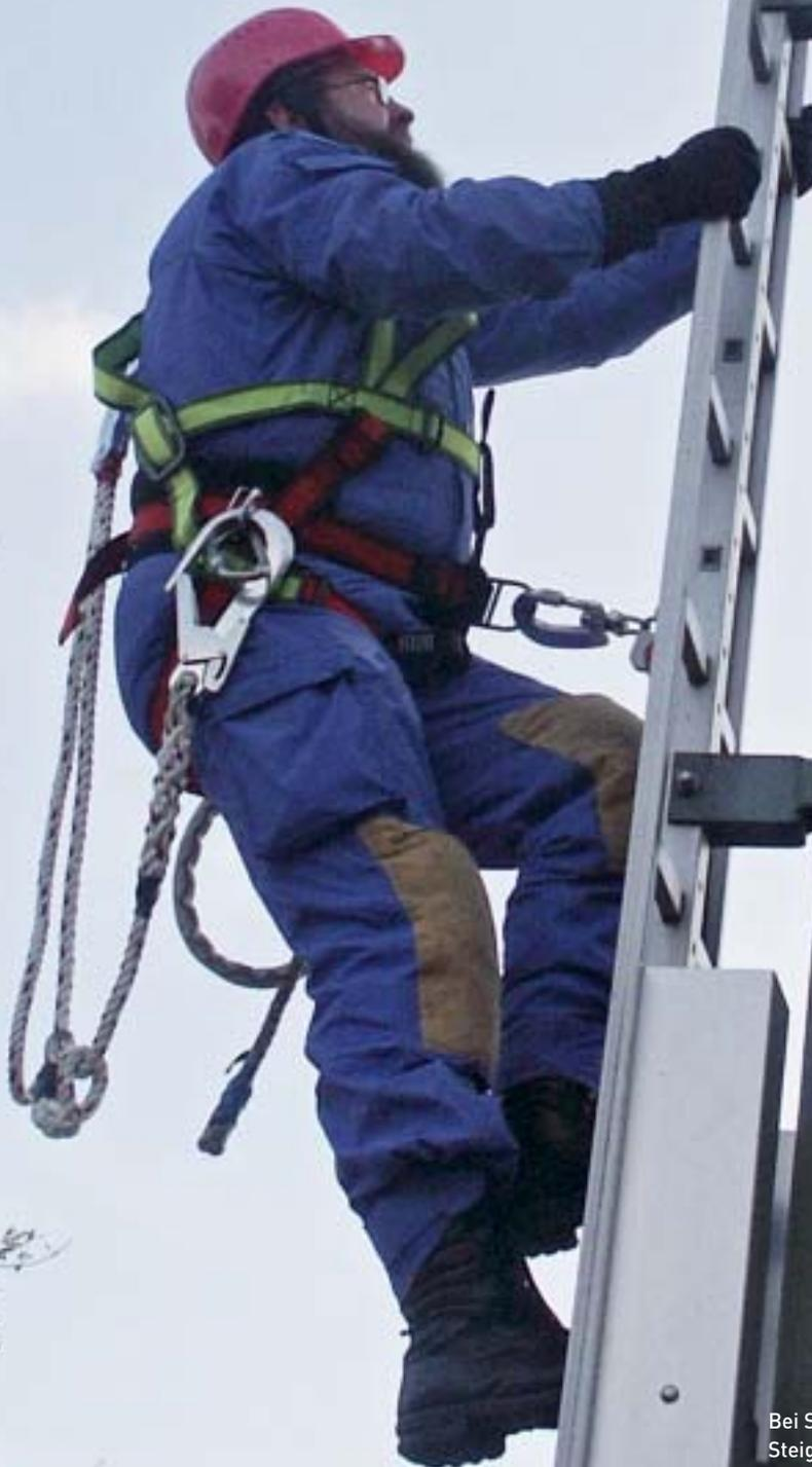
Bei Steigschutzeinrichtungen führt der Steigende ein Auffanggerät an einer festen Führung mit.
