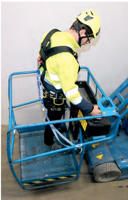
Abb. 1: Längenverstellbare Verbindungsmittel mit Falldämpfer eignen sich besonders für die Anwendung in kleinen Arbeitskörben (Foto: Hahne)
