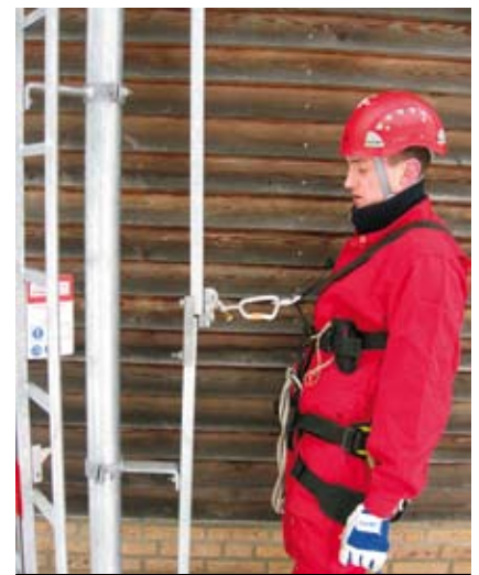
Lösen sich an der Führungsschiene die Verbindungsschrauben, so kann das Auffanggerät ausfädeln. Es kommt zum Absturz der Person.
