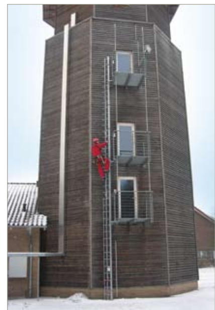
Am Schlauchturm der Kreisfeuerweherschule Gütersloh wurde eine Steigschutzeinrichtung für Ausbildungszwecke installiert.
