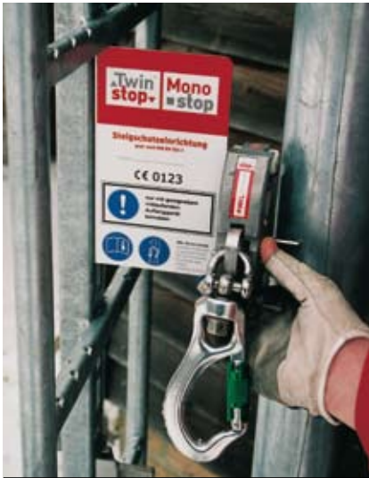
Leiter und Auffanggerät bilden ein System. Eine Kennzeichnung findet man an jedem Einstieg.
