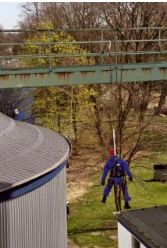
Nach einem Sturz in einen Bandfalldämpfer kommt es zu einer Verlängerung des Verbindungsmittels. Der Beschäftigte ist auf die Rettung durch Dritte angewiesen.
