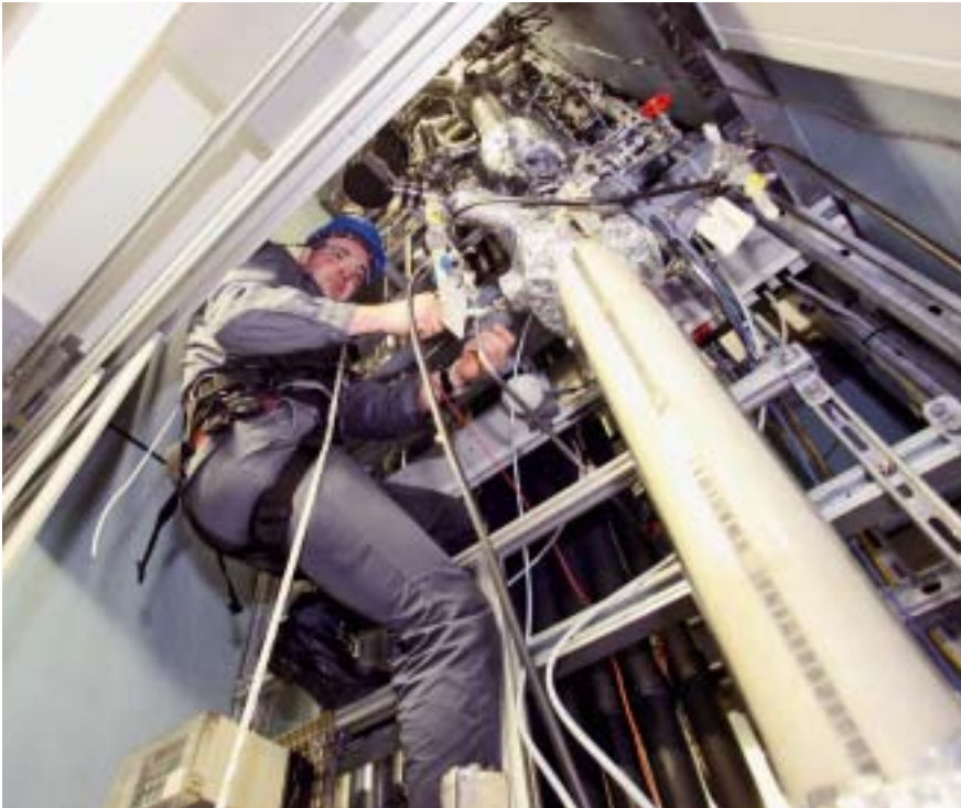
Der Chemikant positioniert sich mit Hilfe der PSA gegen Absturz in der Anlage, damit er seine Arbeiten an den Apparaturen durchführen kann.
