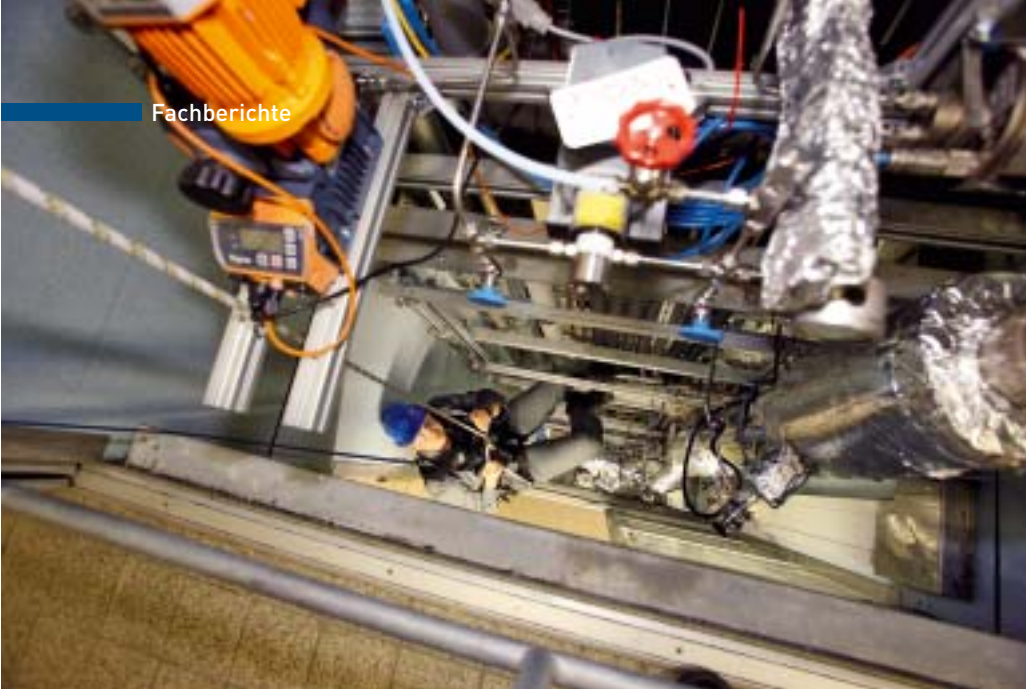
In dem 20 m tiefen Technikumsschacht verwenden die Chemikanten PSA gegen Absturz um die notwendigen Umbaumaßnahmen sicher durchführen zu können.
